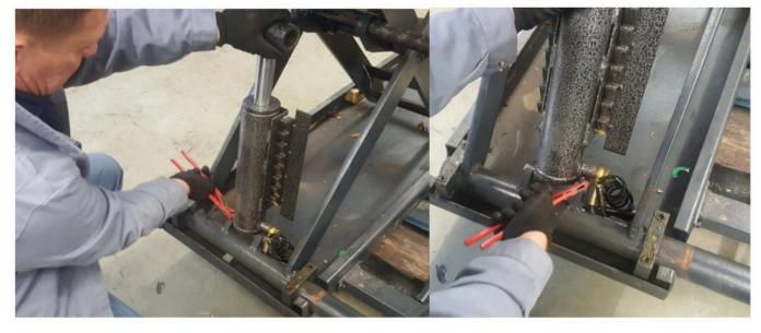
**Schritt 8:** Entfernen Sie den Hydraulik- und Druckluftschlauch.
