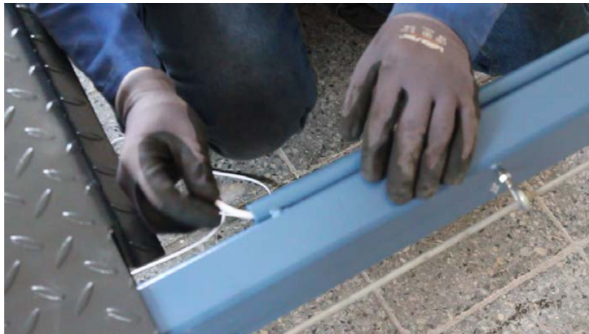
Abbildung 11: Einziehen des Elektrokabels.
