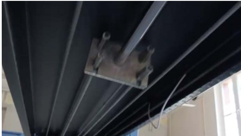
Abbildung 8: Hier sehen Sie, wie die Verschraubung mit der Mittelplatte funktioniert.
