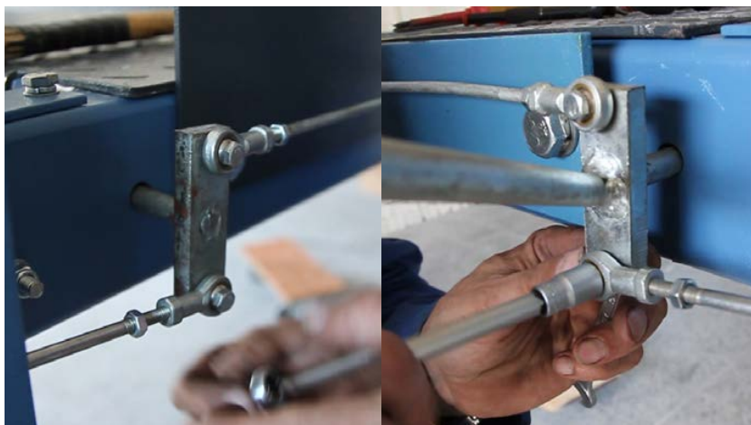
Abbildung 17: Montage der Hebelseilzüge
