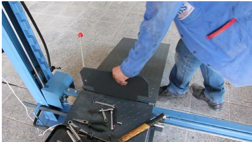
Abbildung 18: Montage der Abschlussplatten
