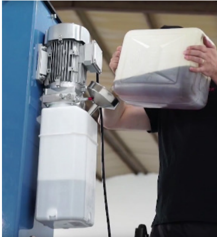
Einfüllen des Hydrauliköls. Abb.7
