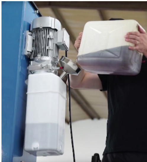
Einfüllen des Hydrauliköls. Abb.8.50
