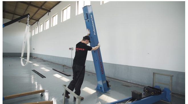
Aufrichten der Säule
